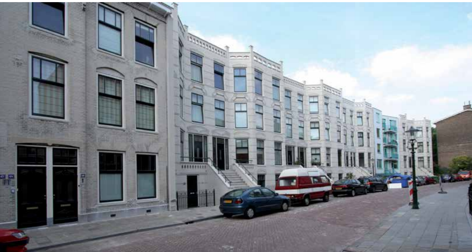
Edificio Sur. Fachada principal
